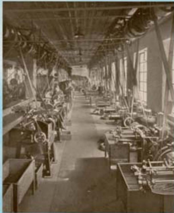
Drahtstricherei, auf der rechten Seite die Drahtstrich- und -abschneidemaschinen, links wird das Abschneiden und Prägen gezeigt
