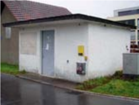
Das Milchhüsli 2013; die Türe verschlossen
