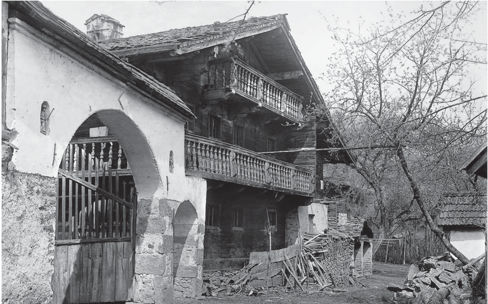
In einem Weiler bei Schaufling im Landkreis Deggendorf hat der Dorfpfarrer Max Maier diesen Bauernhof aus Holz und Stein um 1900 auf eine Glasplatte belichtet. Legschindeldeckung, Schrot und Oberbodenschrot mit gedrechselten Balustern, ein Holzblockbau vom Fuß bis unters Dach: ein klassisches Waldlerhaus. Im steinernen Hoftor spenden kleine Heiligenfiguren in engen Nischen Segen für Haus und Hof.
