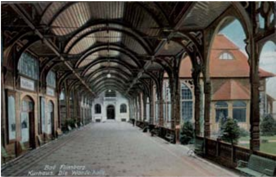
Die Wandelhalle im Kurhaus von Bad Flinsberg bot den Besuchern einen herrlichen Ausblick über die Parkanlage hinweg auf das Isergebirge.
