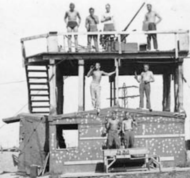
Eine weitere Bauart eines Flakturmes. Das 2-cm-Geschütz ist auf der Plattform deutlich zu erkennen. Rechts vom Turm steht der Sonderanhänger für den Transport der 2-cm-Flak.
